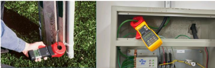
접지저항클램프미터를 활용한 접지 저항 측정 사례
